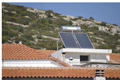
Placas Solares Fotovoltaicas
